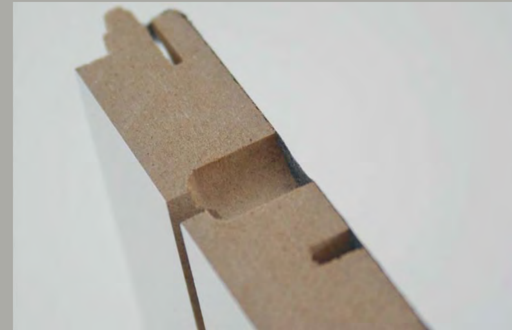
Sezione del risuonatore di Helmholtz nel 4akustik®.
